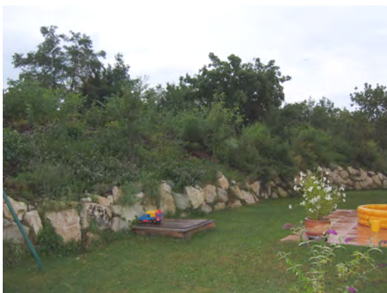
Beispiel für die Einbindung eines Lärmschutzwalls in die Gartengestaltung (Weilheim, Narbonner Ring)
